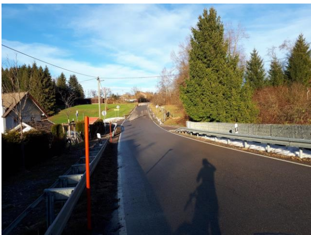
Sicherung Kreuzung – Rottachbrücke nach Wolfis durch FFW
